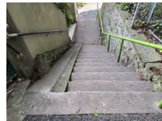
④ 階段を降ります (この先に電柱広告あり)
